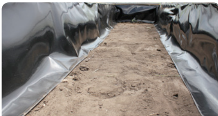
По периметру траншеи кладем мягкий бордюр из плотного черного полиэтилена
